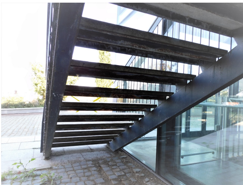
Fot. 11 Stopnice z konstrukcją wsporczą – widok od spodu.
