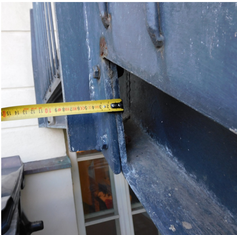
Fot. 16 Konstrukcja poręczy – widok z boku, część dolna.
