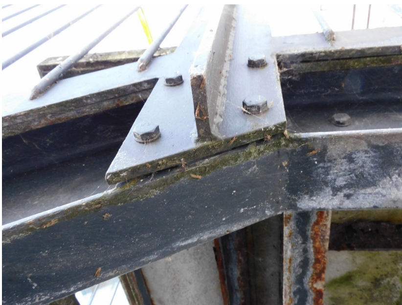
Fot. 14 Konstrukcja poręczy – widok od spodu
