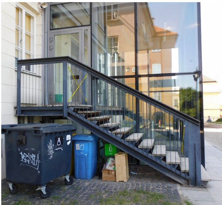
Fot. 7 Widok z boku - schody stalowe zewnętrzne, LEWE.
