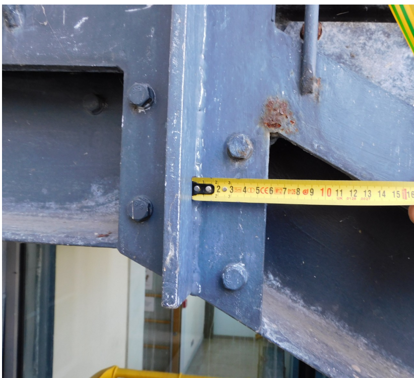
Fot. 15 Konstrukcja poręczy – widok z przodu, część dolna
