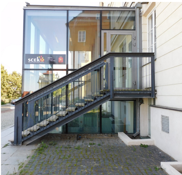
Fot. 8 Widok z boku - schody stalowe zewnętrzne, PRAWE.
