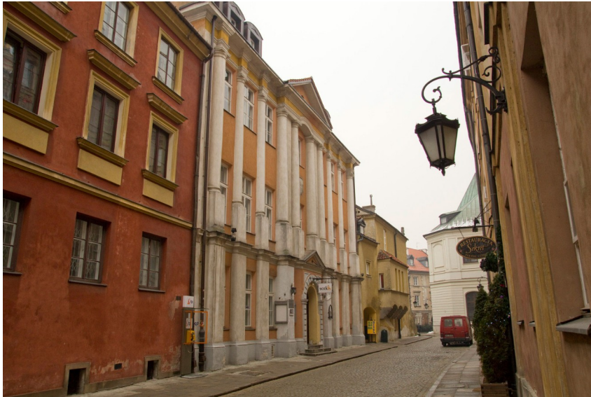
Fot. 3 Widok elewacji frontowej budynku przy ul. Jezuickiej 4 w Warszawie
