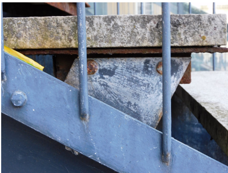
Fot. 9 Przyspawane blachy gr. 10 mm w kształcie zbliżonym do trapezu z wywierconymi dwoma otworami do mocowania stopnic.
