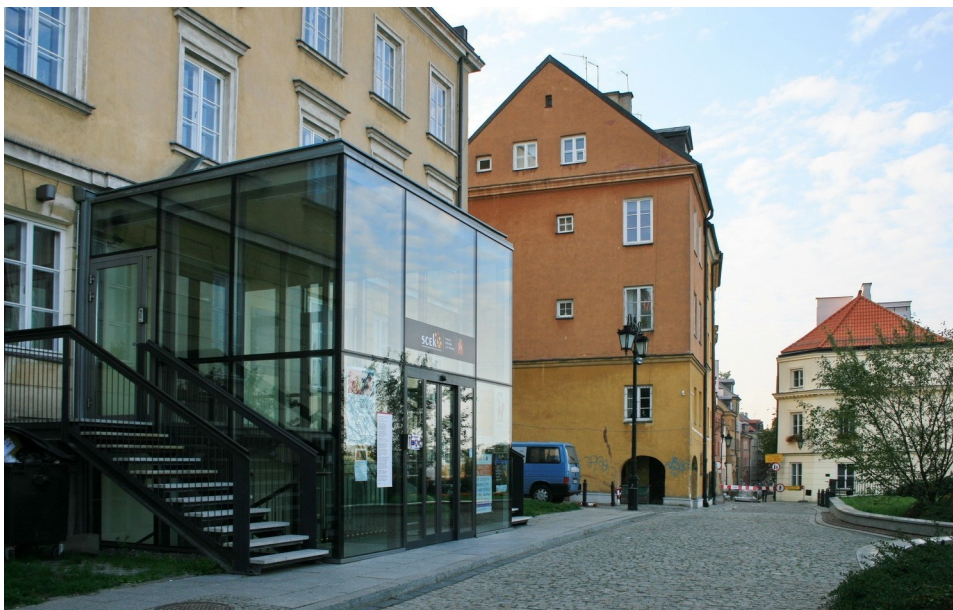
Fot. 4 Widok elewacji od strony ul. Brzozowej w Warszawie. „Szkłana weranda” ze schodami stalowymi zewnętrznymi
