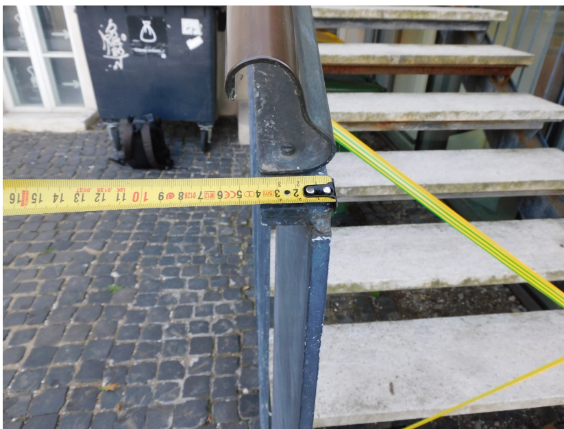
Fot. 17 Pochwył z kształtownika z mosiądzu gr. 4 mm.
