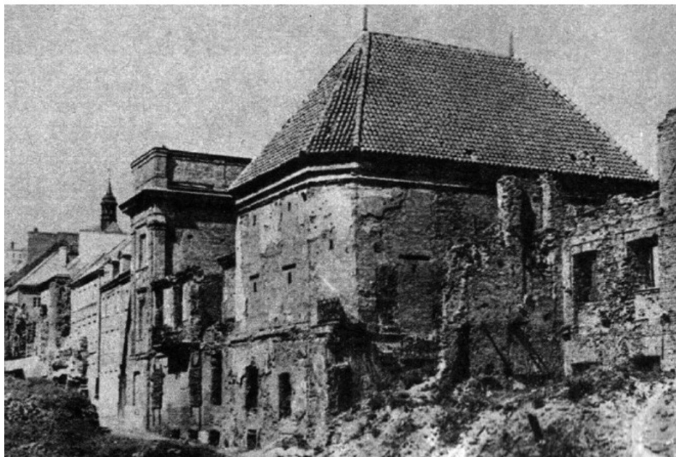
Fot. 10. Baszta Mostowa po spaleniu i zabezpieczeniu. Stan z 1954 r. Źródło: Stolica : warszawski tygodnik ilustrowany. R. 22, 1967 nr 32 (6 VIII) https://mbc.cyfrowemazowsze.pl/dlibra/plain-content?id=1210
