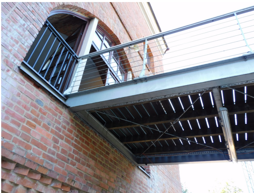
Fot. 17 Podparcie kładki od strony budynku
