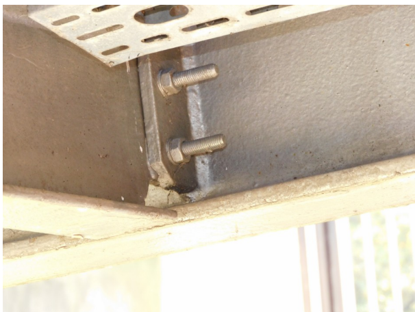
Fot. 18 Sposób mocowania dwuteowników 140 do dwuteownika 300
