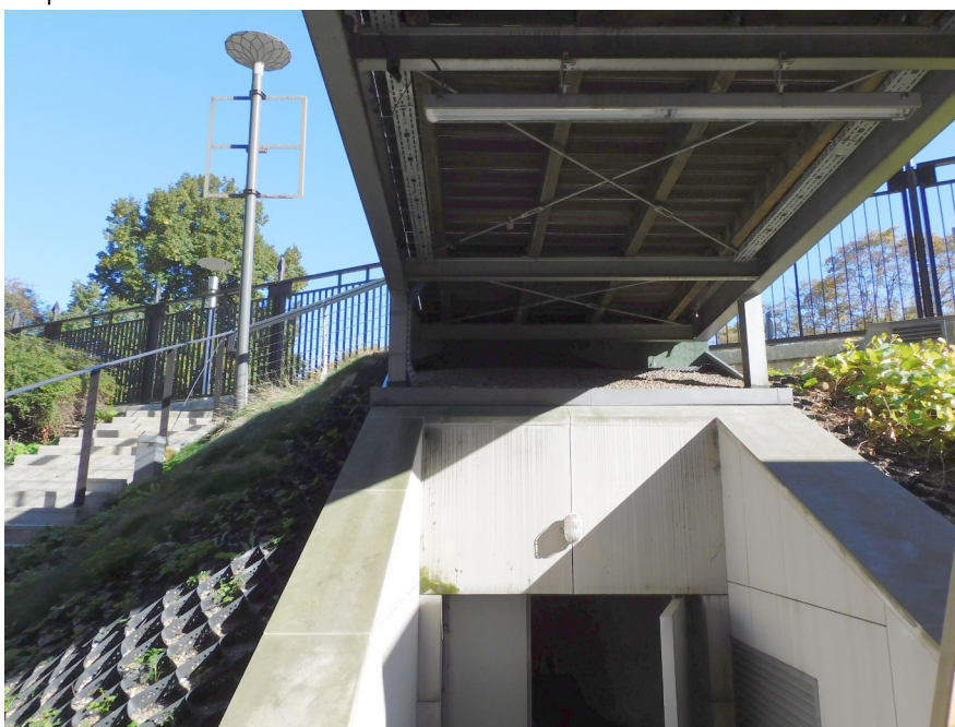
Fot. 16 Podparcie kładki od strony furtki
